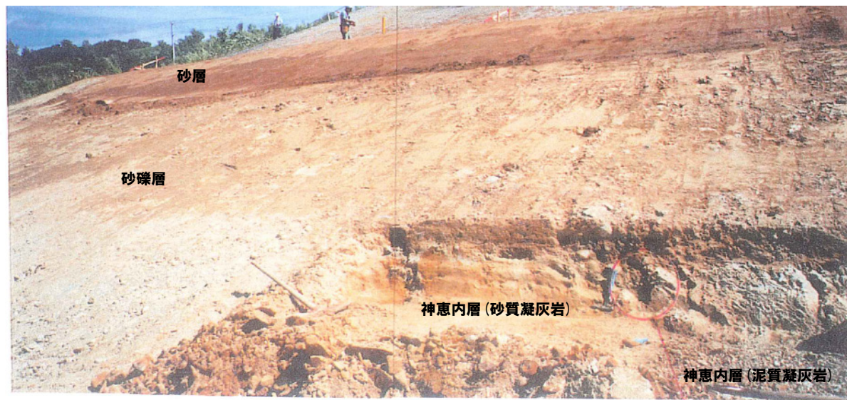
全景写真 (敷地造成工事時確認箇所)
