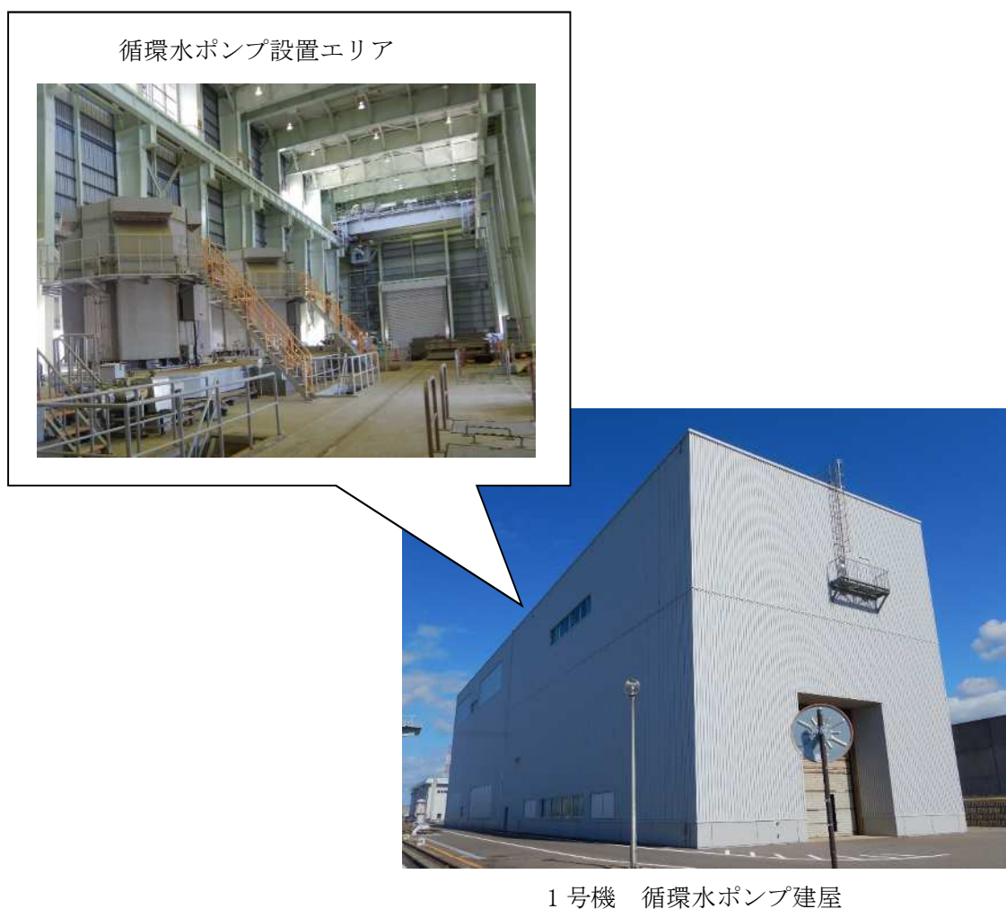
図2 建屋内温度の測定箇所（1号機 循環水ポンプ建屋）
