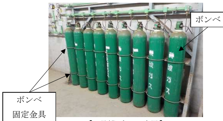
【7号機ボンベ建屋】 二酸化炭素ボンベ
