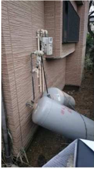
東日本豪雨(常総市の水害)でのLPガスボンベの被災状況の一例 *3
