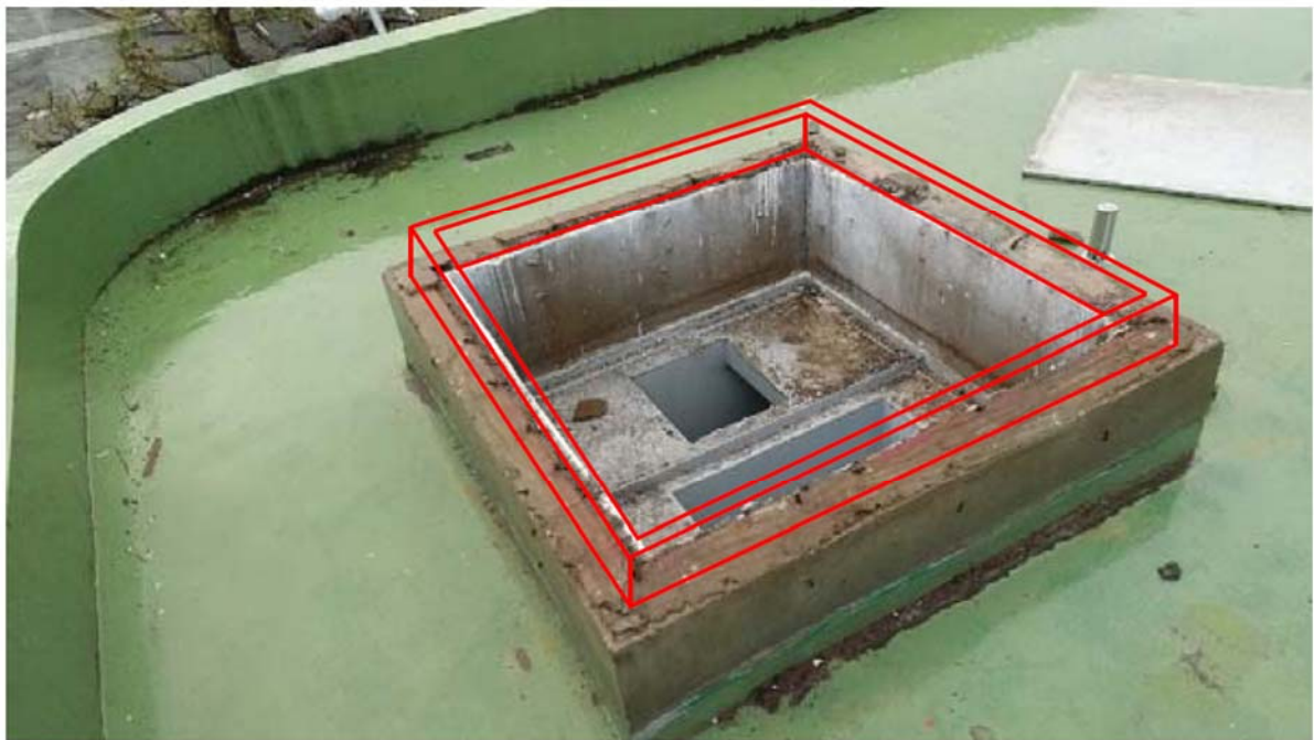
図 4 研究棟屋根基礎部と排気筒底面鉄骨部品との接合の模式図
