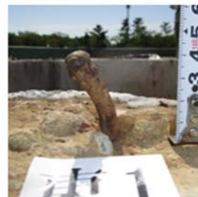
基礎側 (モルタルはつり後)
