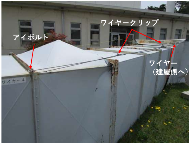
排気筒側：アイボルト、ワイヤークリップ、ワイヤーの位置関係 (ワイヤー1~4：写真はワイヤー4)
