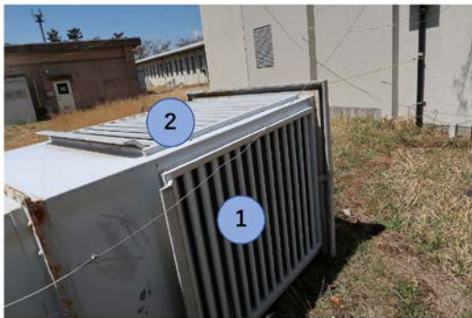
排気筒 ガラリ外側
