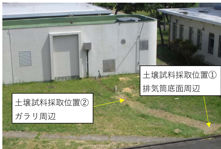
排気筒撤去後の状況。撤去後の土壌を①②の位置で採取してγ線スペクトロメータで測定した。(令和2年6月12日撮影)
