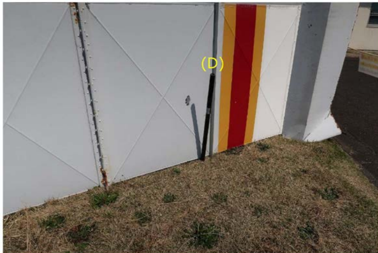
固定措置(C)および(D)の拡大図。排気筒を鉄パイプで固定した。 鉄パイプは土中に約35 cm埋めた。(令和2年4月15日撮影)
