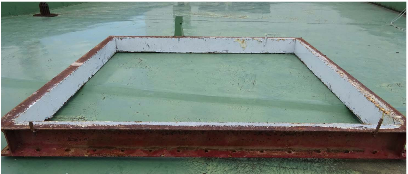
図3 排気筒底面鉄骨部品の位置および写真 (写真は倒壊した排気筒底面から取り外した状態であり、屋根基礎側が上側、排気筒側が下側)
