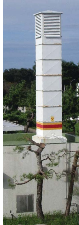
倒壊前の排気筒 (南から撮影)
