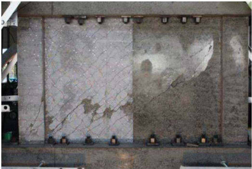
図 3-2 試験体 S-13-D0 最終破壊時写真
