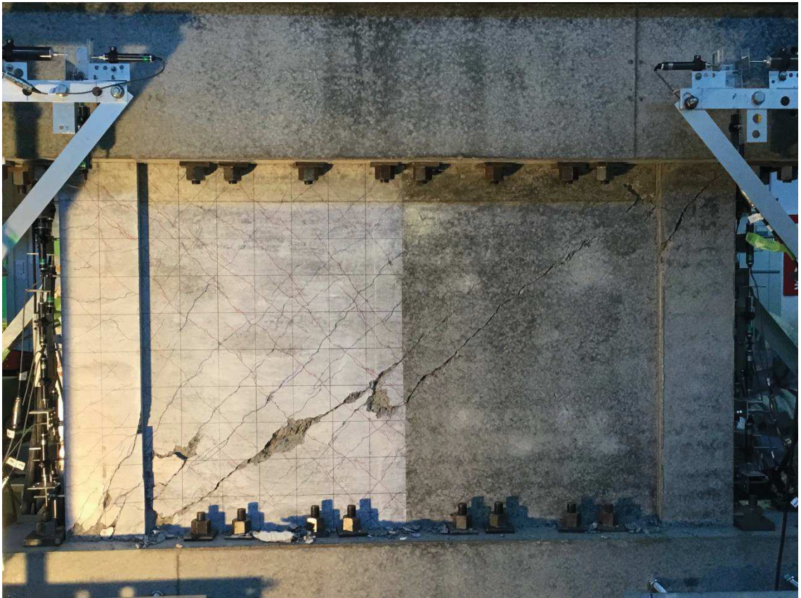
図 2-6 試験体 S-06-D0 最終破壊時写真
