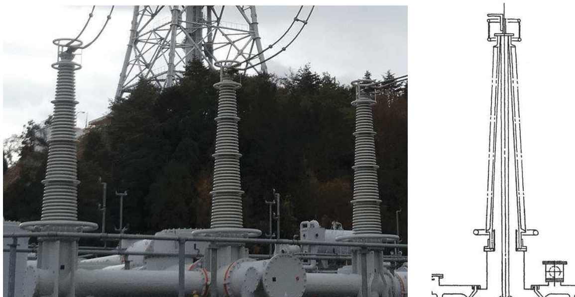
図 1-24 ブッシングの外観及び内部構造図のイメージ図
