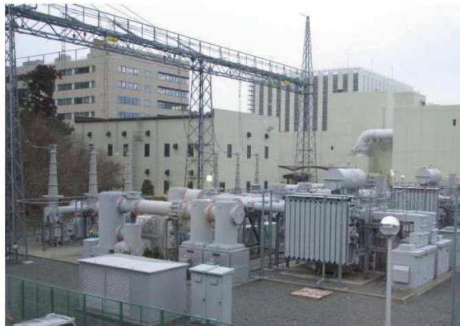
(ガス絶縁開閉装置イメージ)
