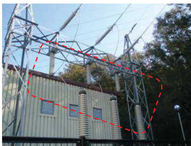
66kV 送電線引込み部（イメージ）
