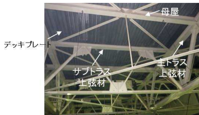
図 5.6-6 原子炉建屋原子炉棟天井の状況
