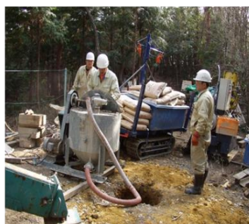
セメント打設
