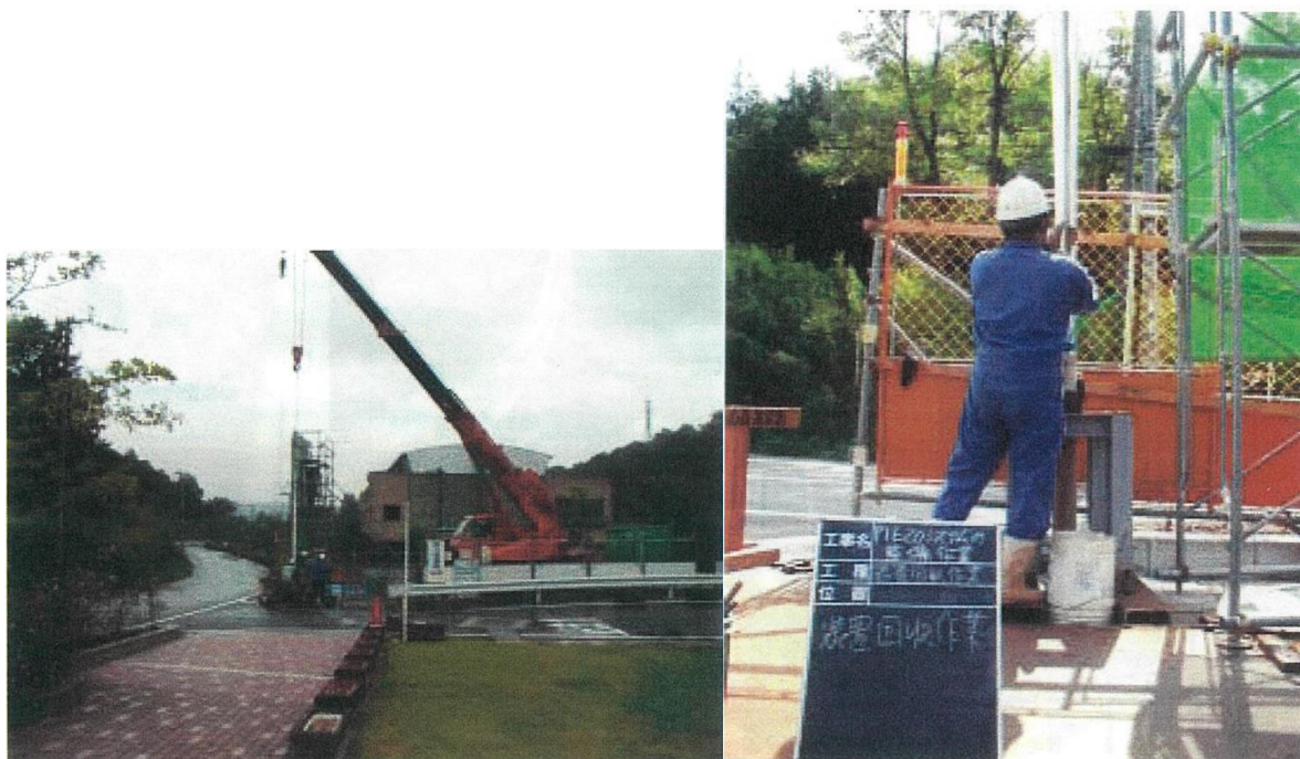
図 4.2-13 PIEZO システム回収作業（DH-2 号孔）
