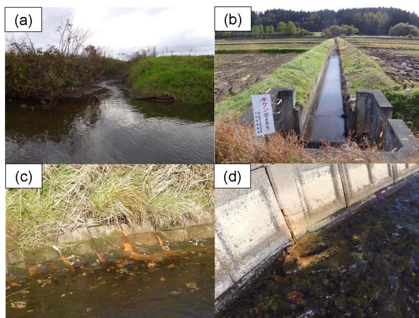
図 3.2.2.3-2 七戸川と砂土路川の Cl 濃度異常地域における支流と湧水
