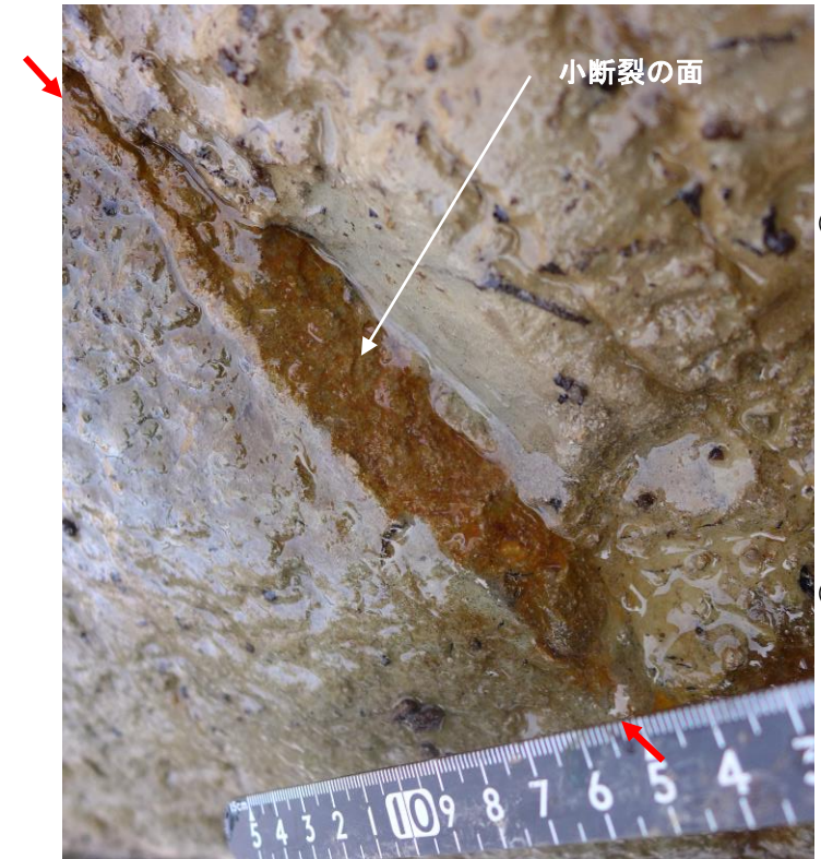
小断裂の面は、平滑ではなく起伏がある 小断裂の面には、条線、鏡肌、粘土等は認められない
