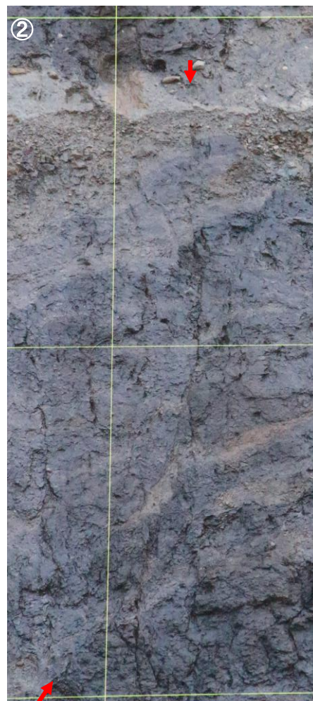
② 上方に延長する小断裂、干裂の可能性あり
