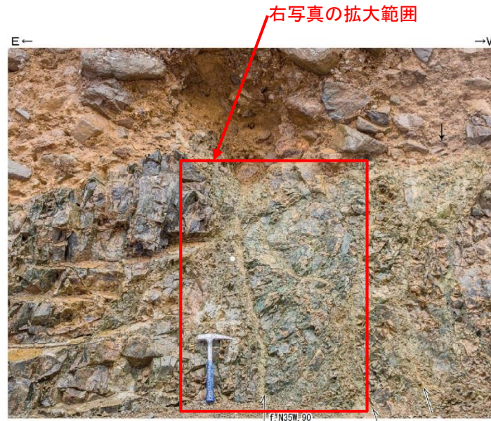
Loc. y104 東通村老部川支流 泊層安山岩質溶岩中の断層。
