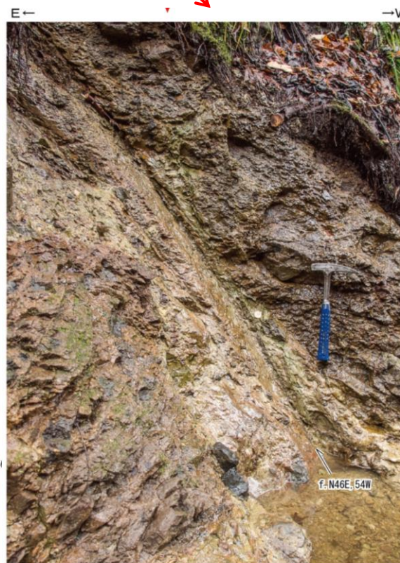
Loc. u320-1 東通村老部川支流 蒲野沢層礫岩中の断層。 断層面沿いには幅数cmのセピオライトを伴う。
