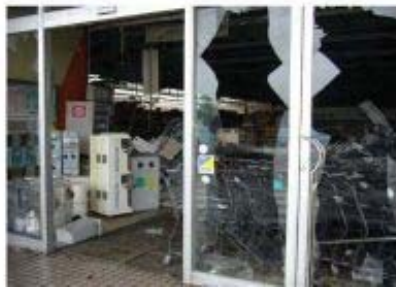
エントランスの窓ガラスの損壊 破損した窓ガラス片の屋内壁面への突き刺さり
