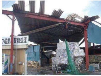
折板の損傷
