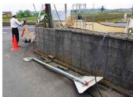
道路標識の倒壊
