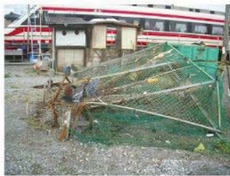
フェンスの著しい変形
