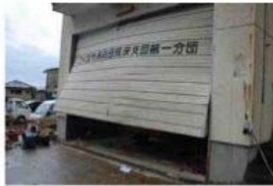
図1.1-4 平成24年5月6日茨城県つくば市で発生したF3竜巻によるシャッターの被害状況 (4)
