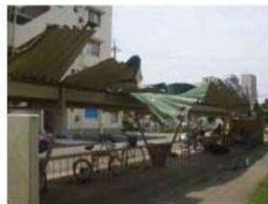
駐車場の折板屋根の著しい変形
