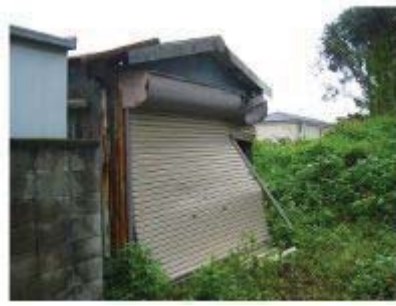
図1.1-3 平成21年7月27日群馬県館林市で発生したF1（F2）竜巻によるシャッターの被害状況 (3)
