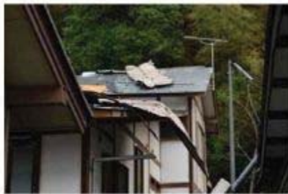
飛来物（鋼板製屋根材）の衝突
