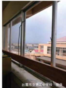
屋外に面した窓ガラス
