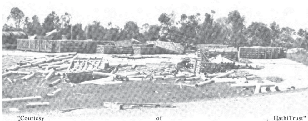
図3.2.1 Grand Gulf原子力発電所の資材置場におけるパイプの散乱状況 (2)
