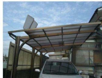
カーポート屋根の損傷
