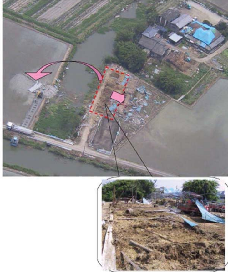
図2.1-1 平成16年6月27日佐賀県で発生したF2竜巻による屋外屋根の被害状況 (9)
