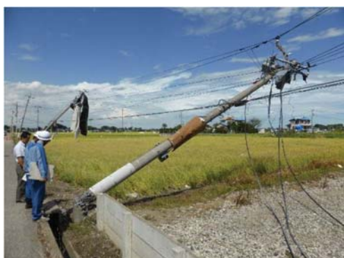
電柱の倒壊
