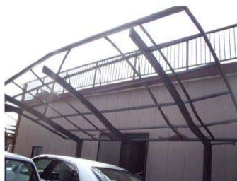
屋外トイレ屋根の損傷
