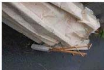
飛散した折板屋根の損傷状況
