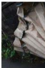
飛散した折板屋根の損傷状況
