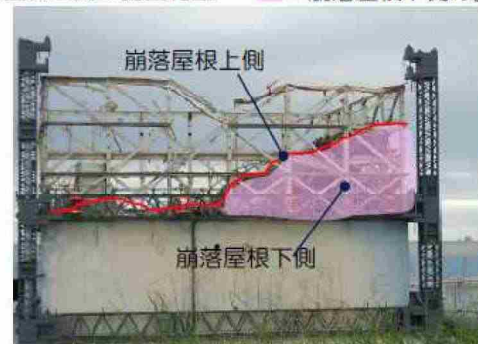
建屋カバー建設中の状況写真(2011年)
