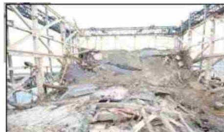
2017年3月30日廃炉・汚染水対策チーム会合／事務局会議 「1号機オペレーティングフロア調査結果（中間）について」
