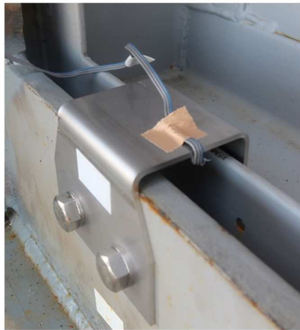
図 2-1 クリップの固定状態及び脱落状態
