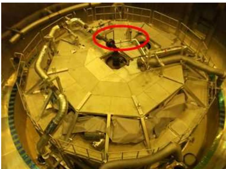
図 1 ベント配管の設置例
