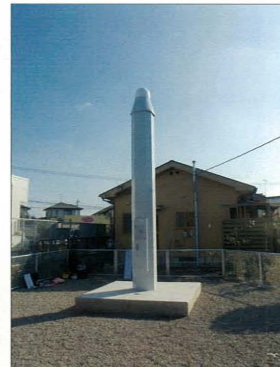
吉野町の機器設置状況
