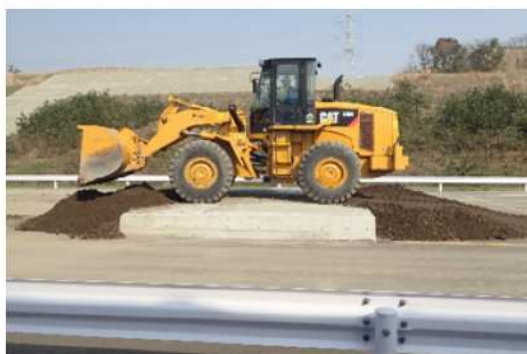
図 12-8 約 50cm の段差の仮復旧 (3)
