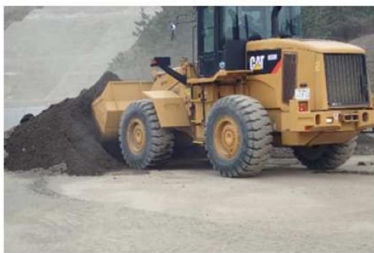
図 12-7 約 50cm の段差の仮復旧 (2)
