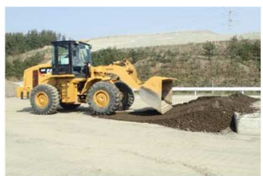
図 12-8 約 50cm の段差の仮復旧 (3)
