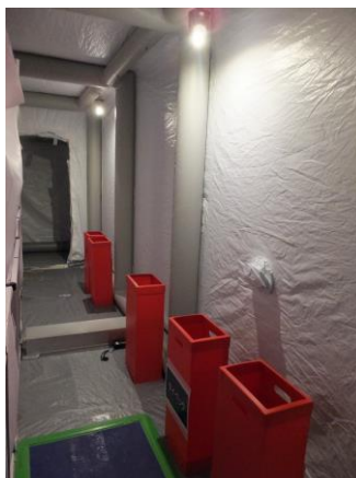
図 1.2-15 乾電池内蔵型照明（ランタンタイプ）確認状況
