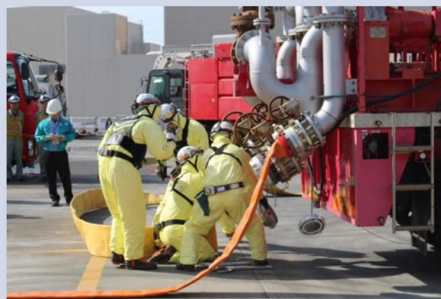
可搬型注水ポンプ車
