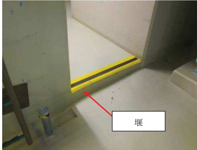
図 4-1 漏えい油の拡大防止対策の例
