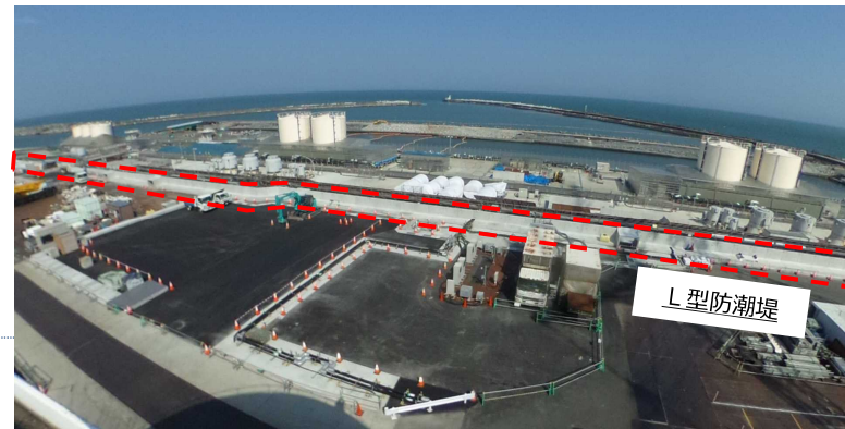
L型防潮堤施工後(2020年4月4日撮影)
