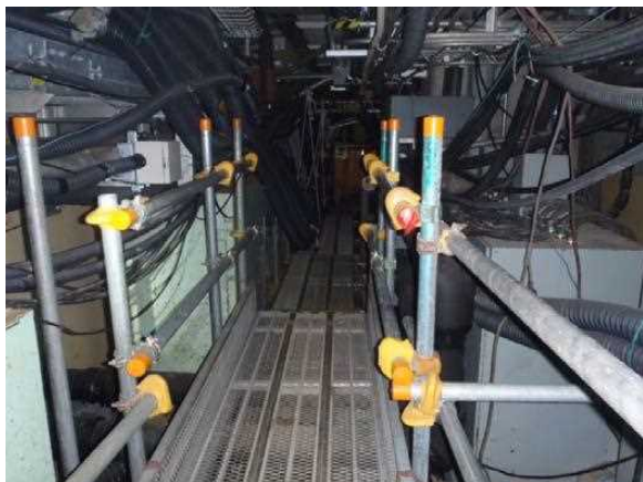
写真1：堰設置予定箇所
