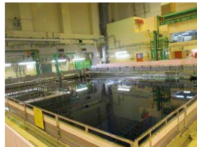
①使用済燃料貯蔵プール全体
