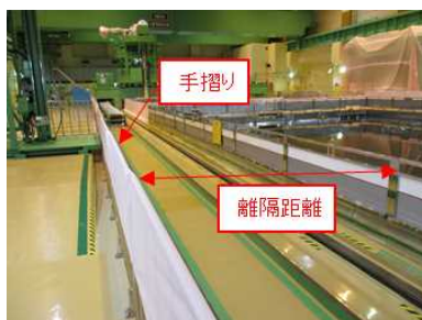
②使用済燃料貯蔵プール 南側側面
