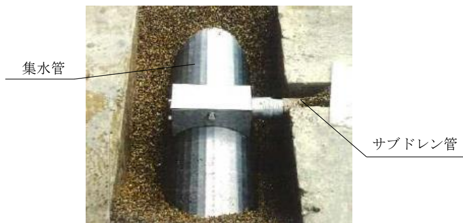
第3-5図 集水管及びサブドレン管敷設状況
