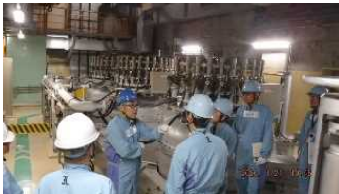
写真 2-1 新検査制度の試運用の確認 (泊原子力発電所、令和元年 1 月 21 日実施)
