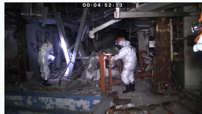
現場調査の様子(3号機原子炉建屋内)
