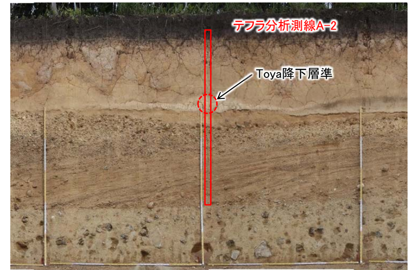
法面④詳細画像
