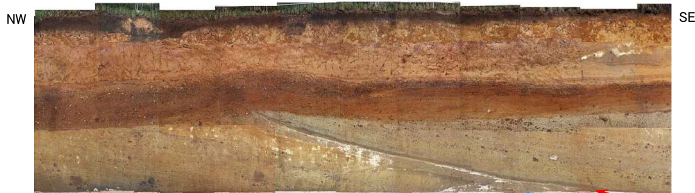
Ts-6法面 写真
