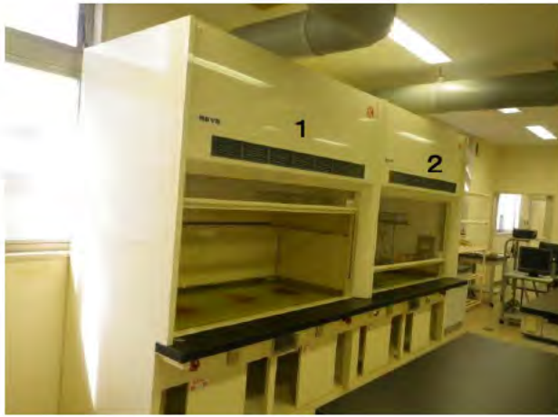
ドラフト1・2外観
