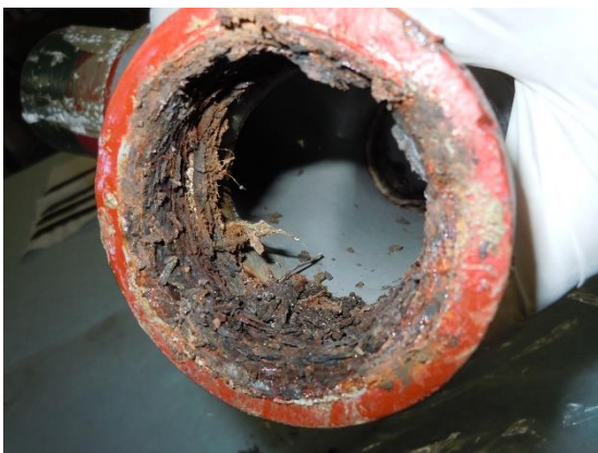
断面写真 1. 継手の縦管との接続部
