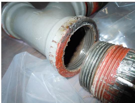
写真 18. ⑧部分_排水管の継手との接続部
