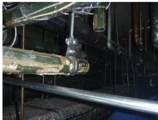
写真 21. 排水管接続部の切断
