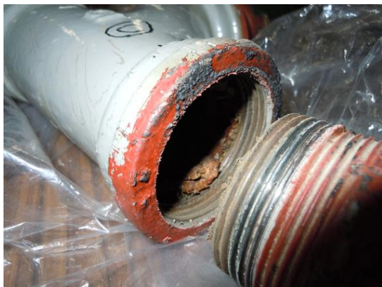
写真 19. ㊸部分_排水管の継手との接続部
