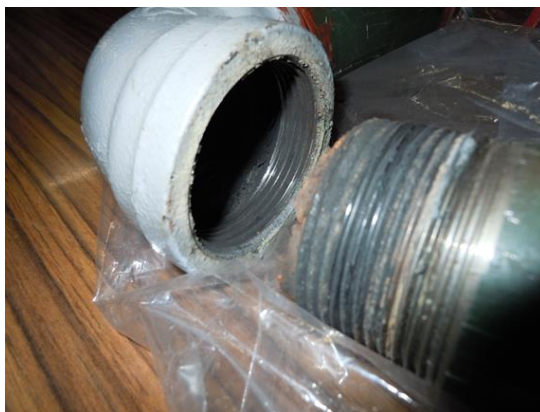
写真 14. ⑤部分_排水管の継手との接続部
