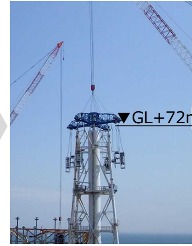
18ブロック解体後 (2020年4月8日)
