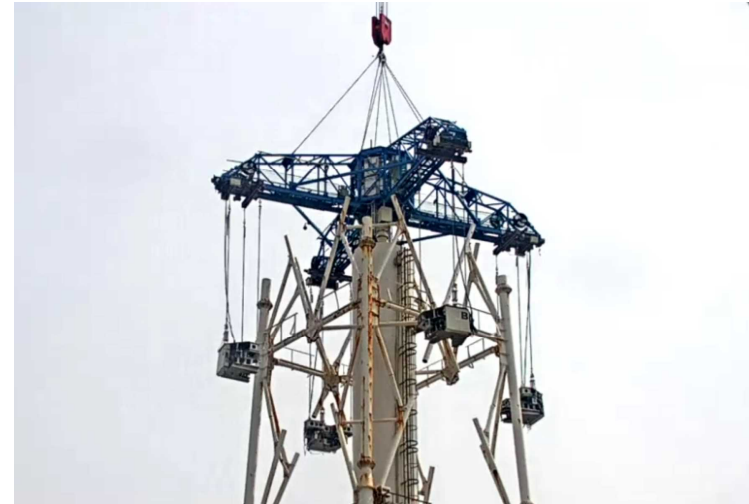
19ブロック目鉄塔解体作業状況(4月15日)
