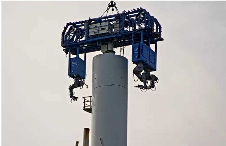
18ブロック目筒身解体作業(4月7日)
