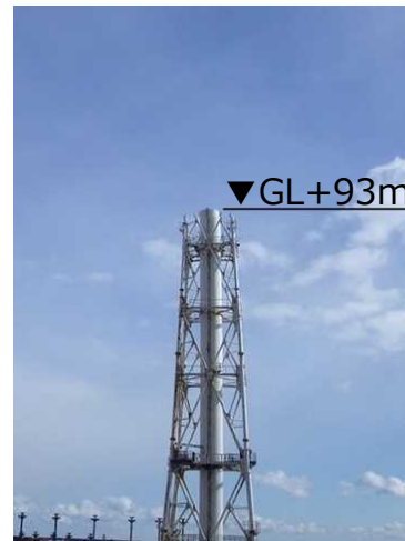
11ブロック解体後 (2020年2月4日)
