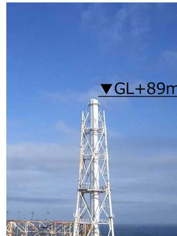
12ブロック解体後 (2020年3月9日)
