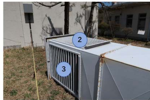
排気筒 ガラリ外側
