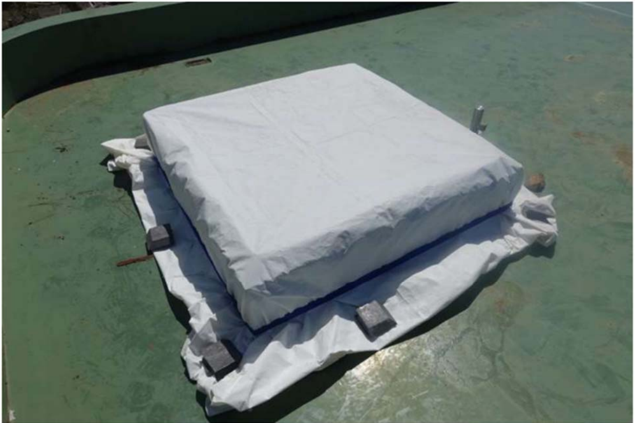
養生（第二段階）後の開口部
