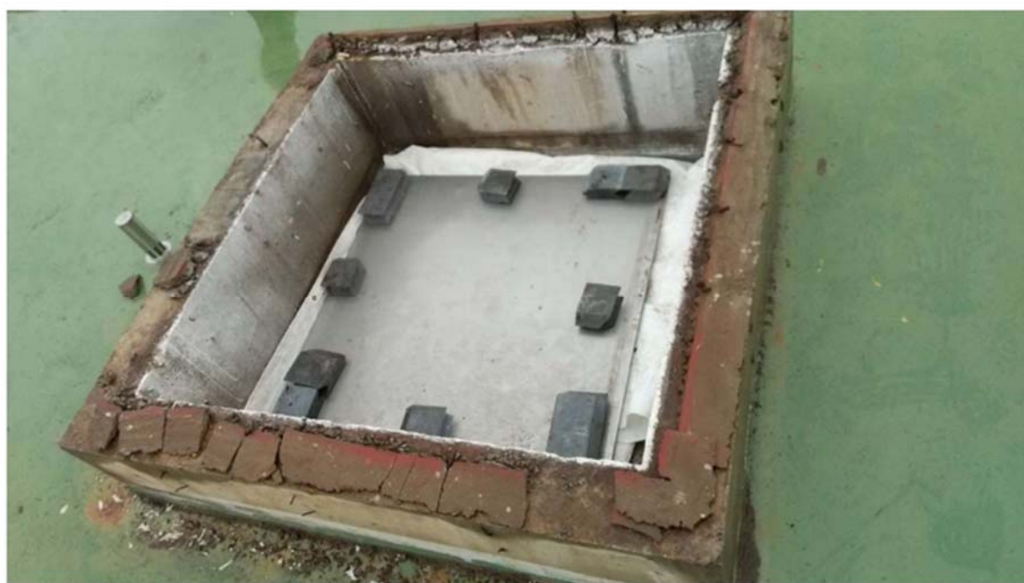
養生（第一段階）後の開口部
