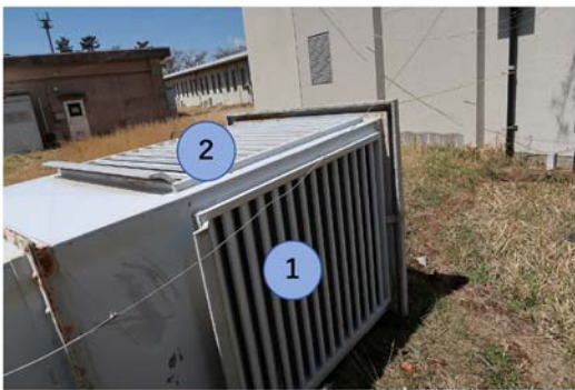
排気筒 ガラリ外側
