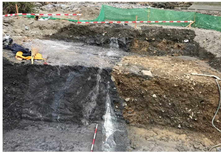
図 2.48 トレンチ法面の写真（西面）
