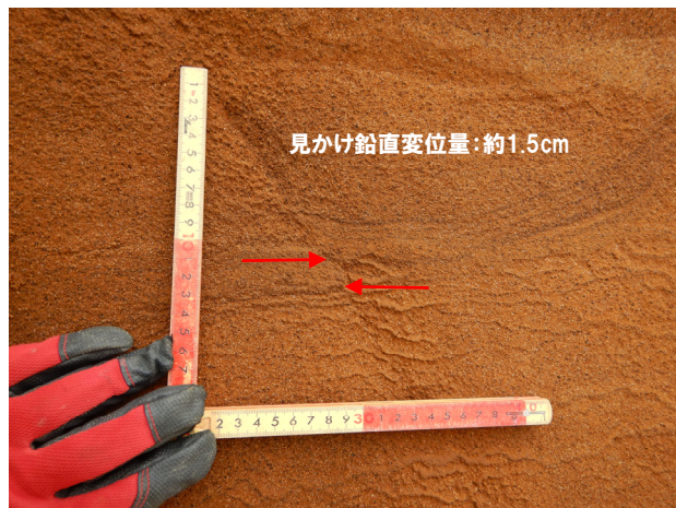
⑦-2 見かけ鉛直変位量測定箇所
