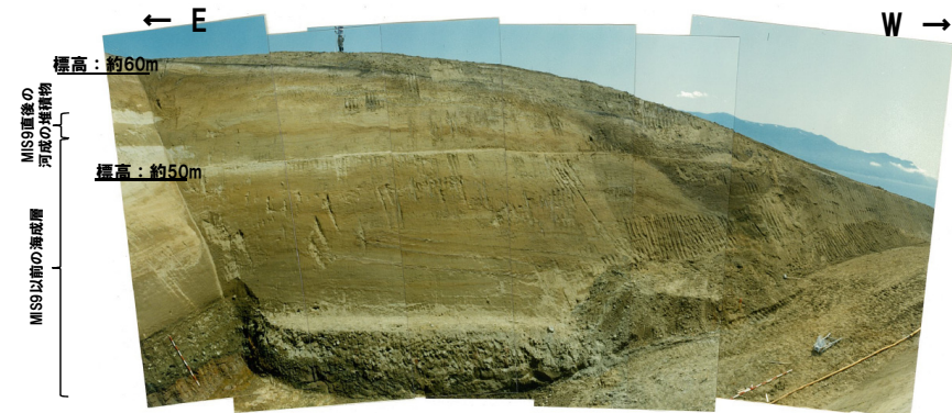
写真2 南側壁面を望む (昭和57年秋頃撮影)
