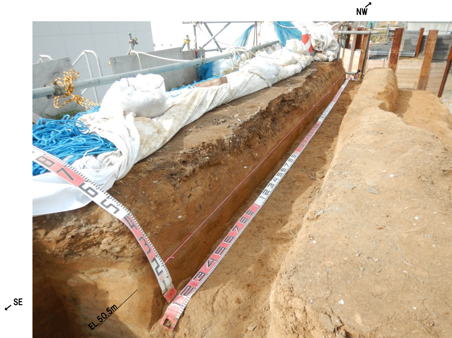
開削調査箇所(南側) 追加人力掘削調査 写真①(解釈線なし)
