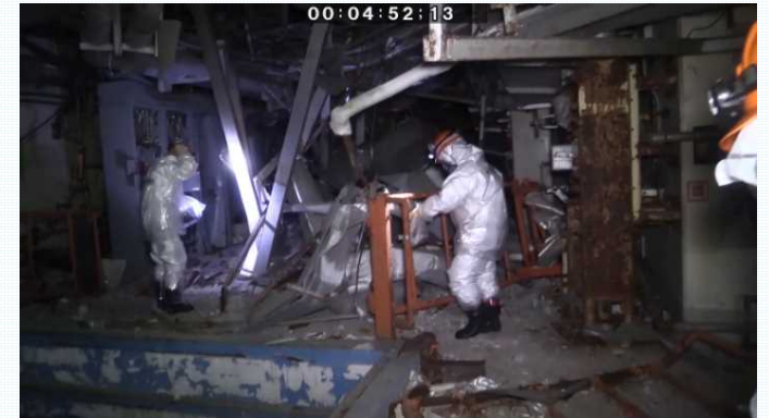
現場調査の様子(3号機原子炉建屋内)
