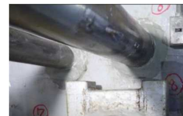
2号機放射性流体ダクト建屋貫通配管
