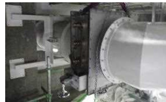
換気・空調設備の工事状況の例
