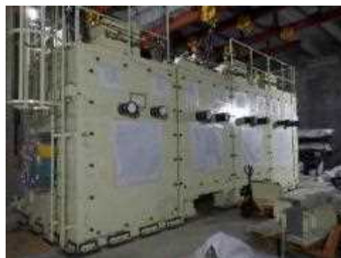
鉄セル本体据付作業状況の例
