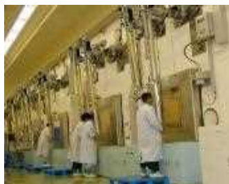
コンクリートセルの例
