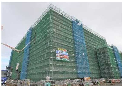
建屋工事全景写真
