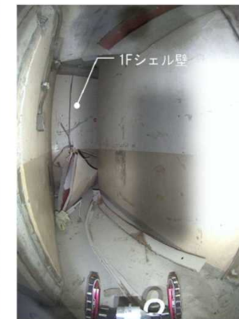
建屋内状況写真(1階)
