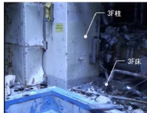
⑤ 3F床（大物搬入口東側）
