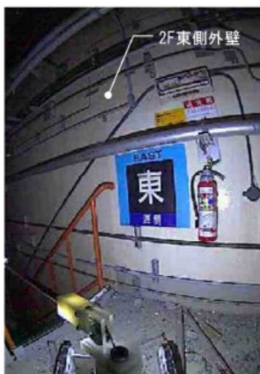
① 2F階段口東側外壁
