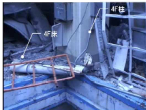
⑤4F床（大物搬入口東側）
