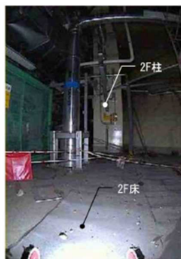
② 2F床及び中間部の柱
