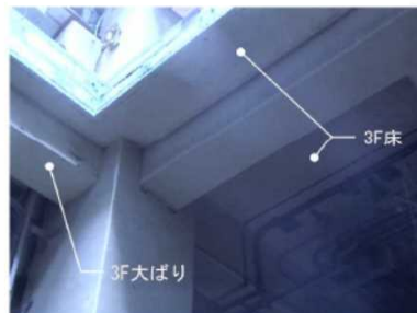
② 3F大ばり交差部(R6通り×RF通り)
