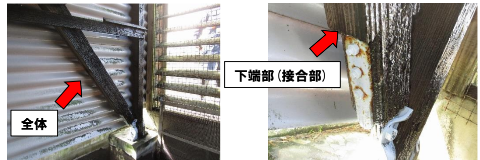
(c) 針貫入試験において針貫入深さが最大となった箇所(5/E~F)
