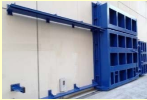
浸水防止扉の設置
