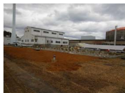
倒壊した二次冷却塔の撤去状況
