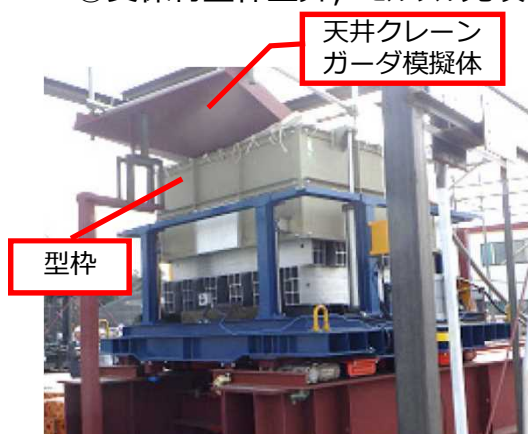
④支保材型枠上昇，モルタル充填
