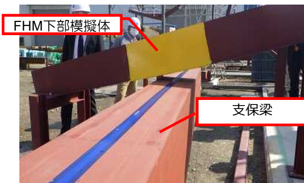
②支保梁挿入
