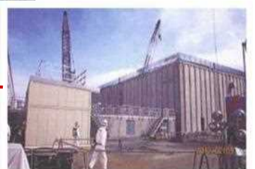
廃スラッジ一時保管施設
