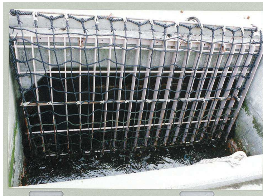
1号炉取水口固定式バースクリーン
