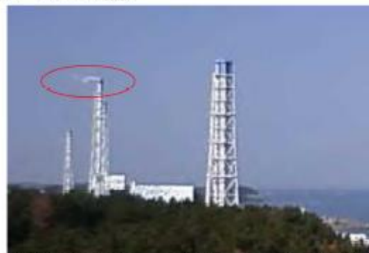
3, 4号機 排気筒から山側にうっすらと蒸気のようなものが見える (15:00撮影以降の写真では確認できず)
