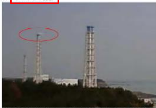
3, 4号機 排気筒から海側にうっすらと蒸気のようなものが見える (11:00、12:00撮影の写真では確認できず)
