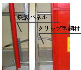
(A) 鉄製パネルと胴縁の接続
