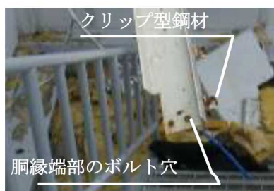
(B) 胴縁端部のボルト穴
