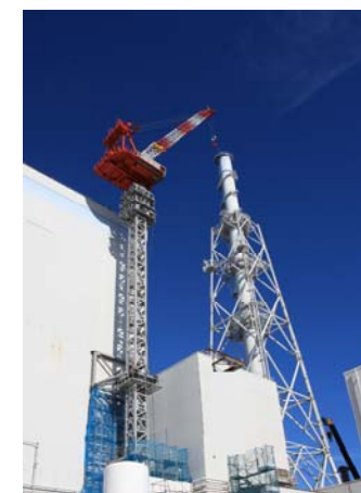
揚重作業用 タワークレーン設置
