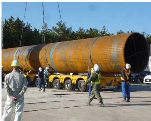
防潮堤鋼管杭の搬送
