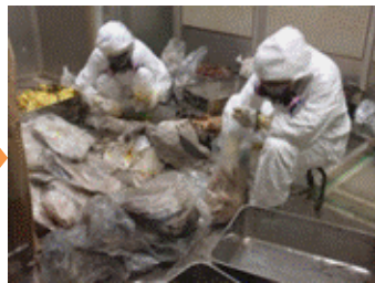
養生材の除去
