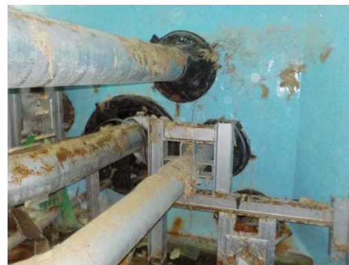
①配管ダクト内の状況
