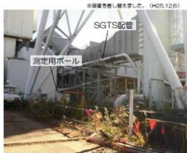
測定実施状況写真
