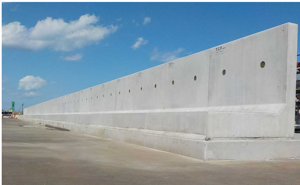
L型擁壁の据付状況（約100m）
