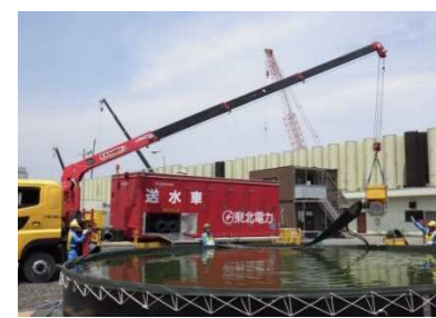
水中ポンプの設置
