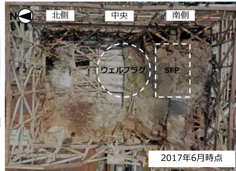
オペフロ上の崩落屋根状況（平面）
