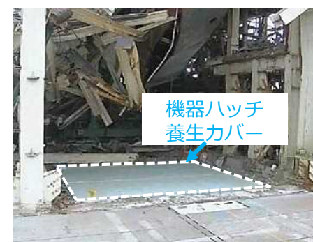
撤去後の西面、養生設置後（3月6日）
