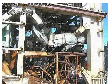
撤去後の南面（11月21日）
