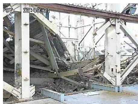
撤去後の東面1（12月7日）
