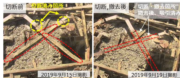
写真② 屋根鉄骨切断撤去状況
