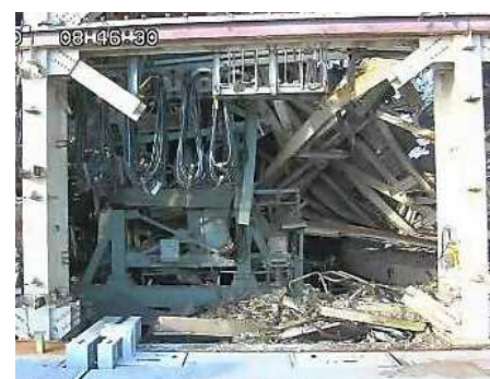
撤去後の東面2（12月20日）
