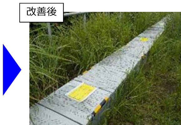
高圧ケーブル (トラフ化・防護板設置)
